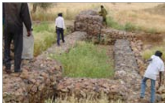
Déversoir d'une digue filtrante avec bassins de dissipation. Source : PGRNG Mauritanie
