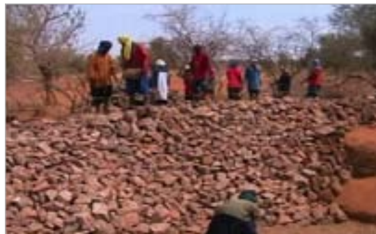
Fermeture d'un ravin par une digue filtrante. Source : PGRNG Mauritanie
