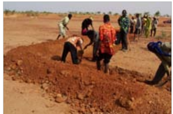
Construction des banquettes. Source : CILSS
